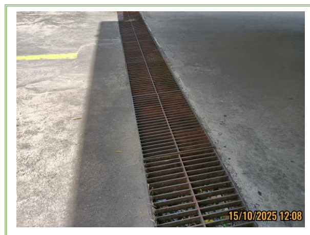
รูปที่ 3-31 รางระบายน้ำบริเวณทางเข้าอาคารจอดรถ
