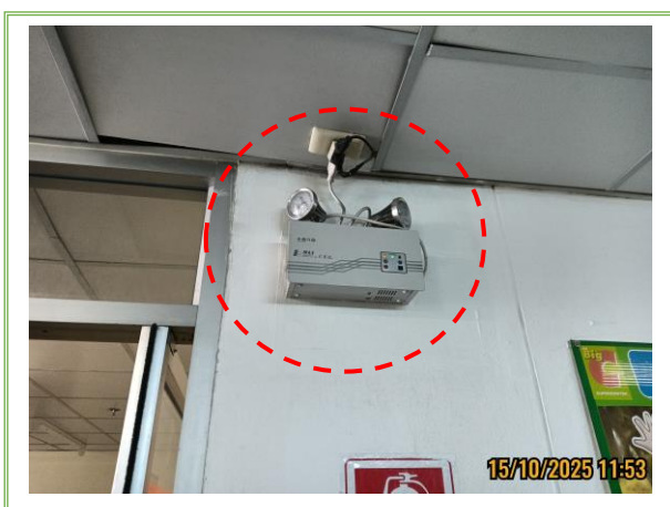
รูปที่ 3-51 ไฟส่องสว่างฉุกเฉิน
