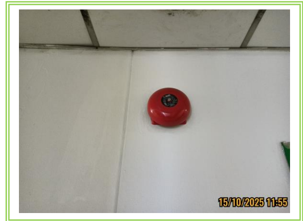
รูปที่ 2.7-2 อุปกรณ์เตือนภัยแบบกระดิ่ง (Alarm Bells)
