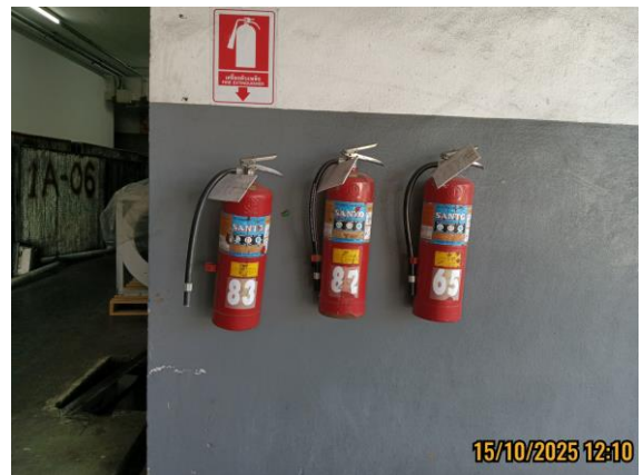
รูปที่ 3-44 ถังดับเพลิงชนิดผงเคมีแห้งติดตั้งตามจุดต่างๆ รอบพื้นที่โครงการ
