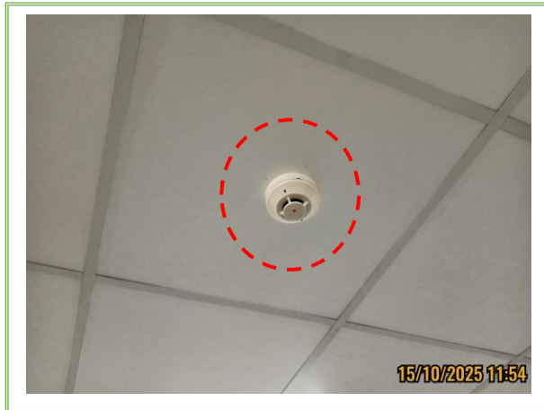
รูปที่ 3-47 เครื่องตรวจจับควัน
