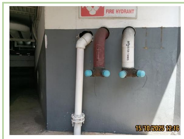
รูปที่ 3-49 หัวรับน้ำดับเพลิงภายนอกอาคาร
